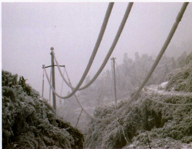
图 4.20.2 2008 年 1 月 26 日广西资源县电线积冰 (桂林市气象局提供)
