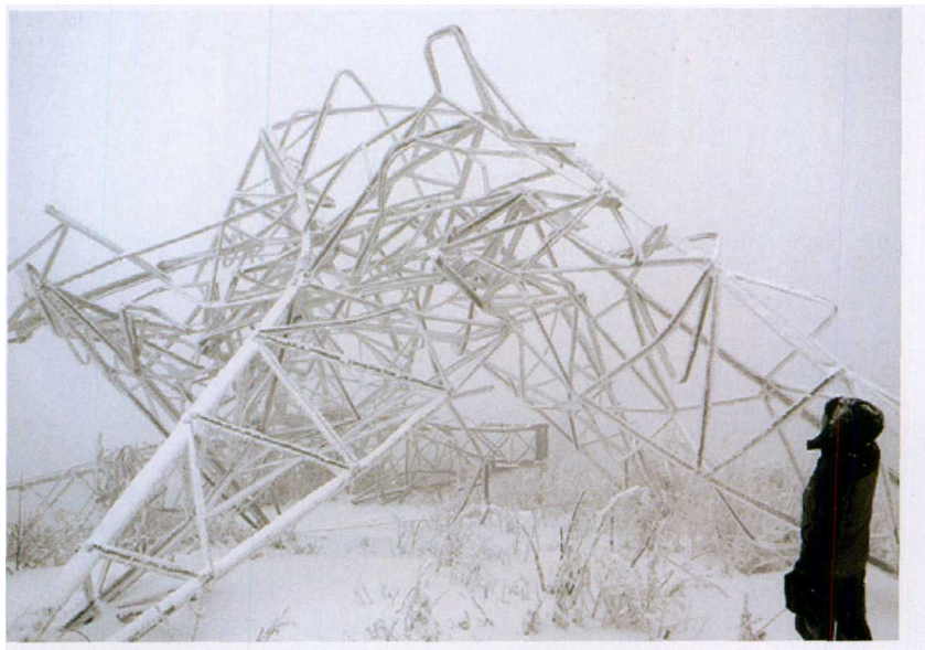
图4.12.2 2008年1月17日积雪压塌大别山区腹地宜华输电线路 (安徽省气象局提供)
