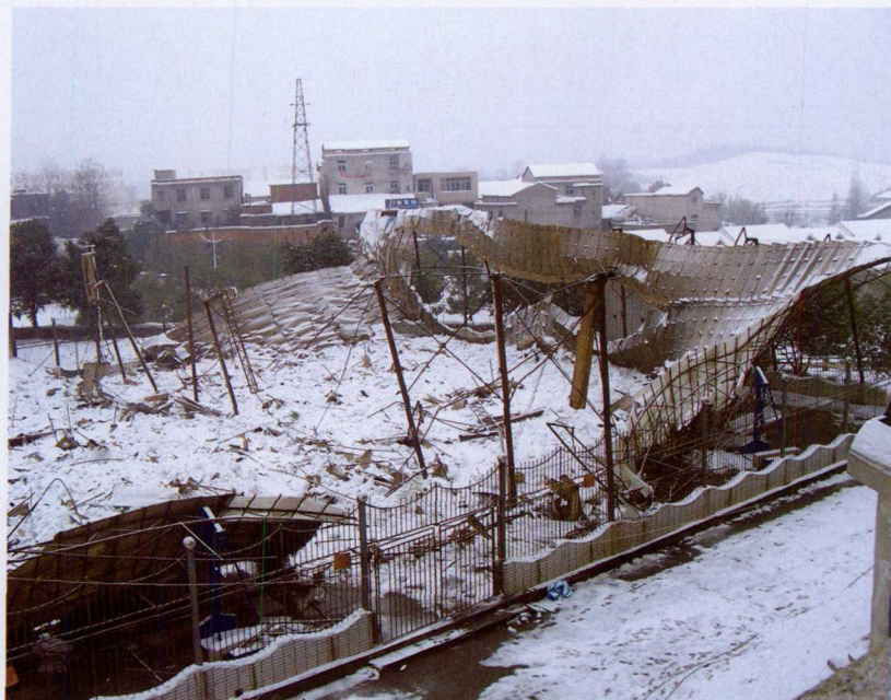
图 4.17.2 2008 年 1 月 31 日湖北省咸宁学院篮球场积雪压垮风雨棚 (咸宁市气象局提供)
