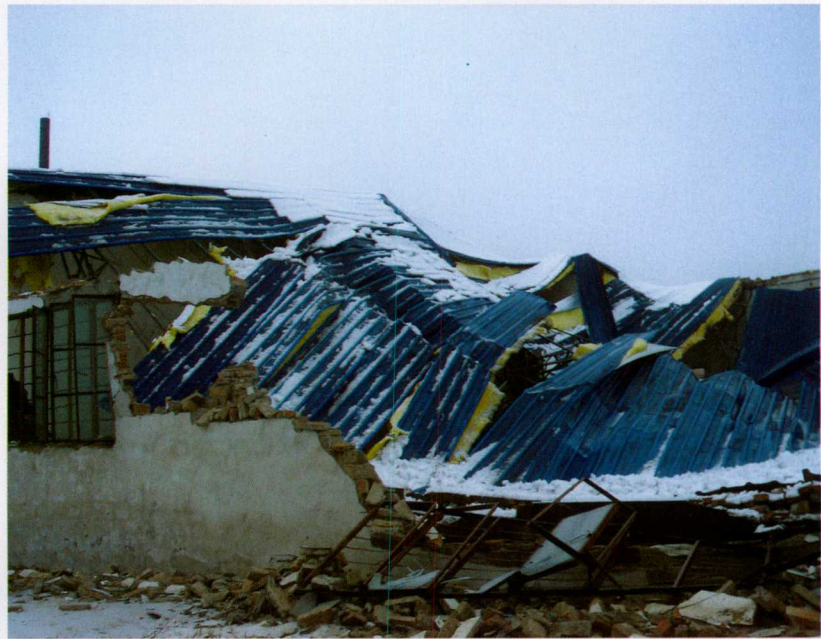
图 4.9.2 2008年1月28日上海市嘉定区南翔镇积雪造成简易厂房倒塌 (嘉定区气象局提供)
