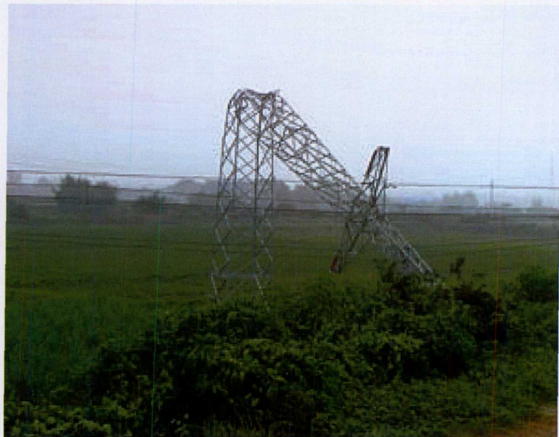
图 4.10.2 9月20日江苏省宜兴市龙卷风和冰雹天气造成电线杆倾倒和供电塔折断（宜兴市气象局提供）
