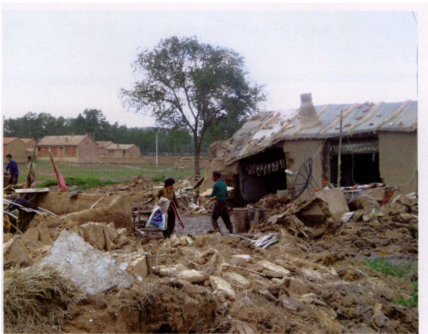
图4.3.2 2008年6月29日河北省康保县雷雨大风导致农户房屋倒塌 (康保县气象局提供)
