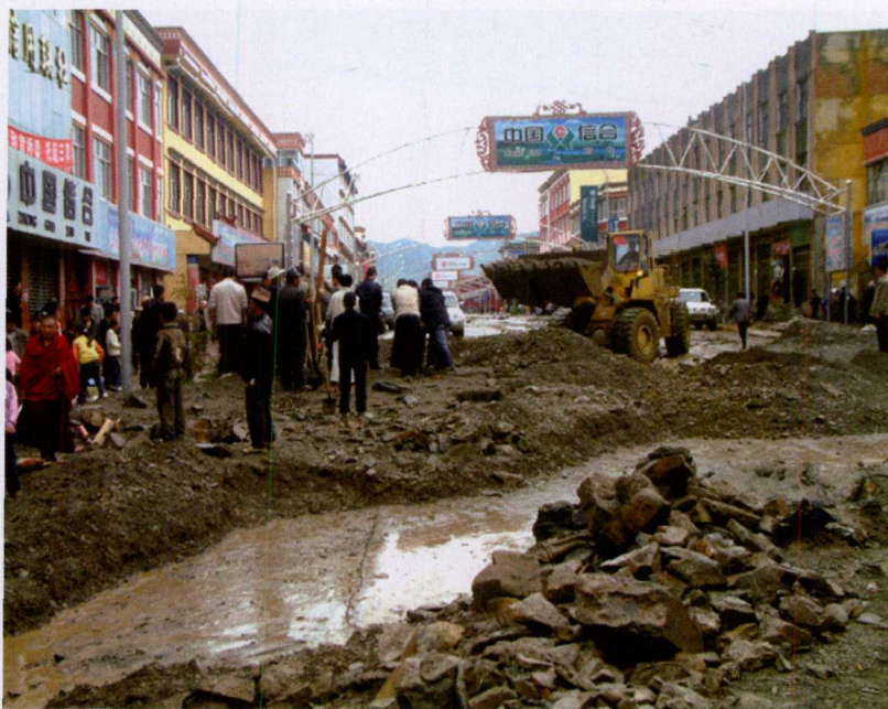
图 4.28.2 2008年8月19-20日甘肃省夏河县城泥石流灾害 (夏河县气象局提供)
