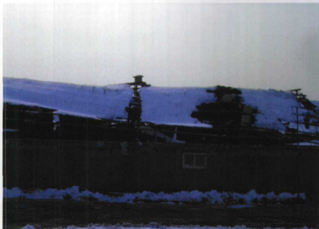
图 4.15.1 2005年12月8日山东省荣成市受大雪损害的鱼种育苗车间(山东省气象局提供)
