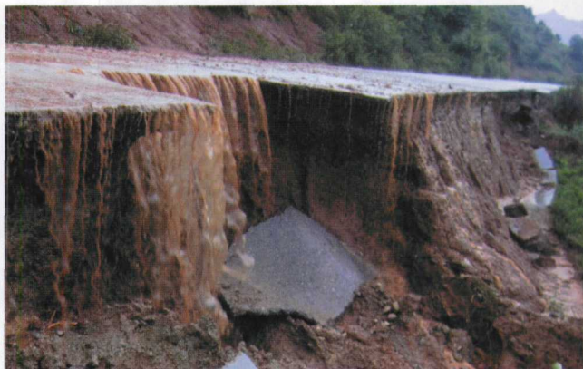
图 4.28.2 2005年7月1日甘肃省天水市麦积区发生暴雨洪涝导致公路损毁(天水市气象局提供)
