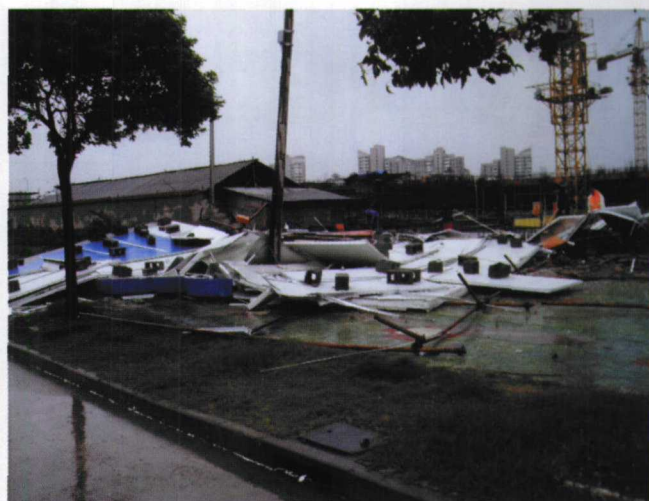
图 4.9.2 2005 年 8 月 6 日上海金山区受“麦莎”台风影响，工棚被大风刮倒（金山区气象局提供）
