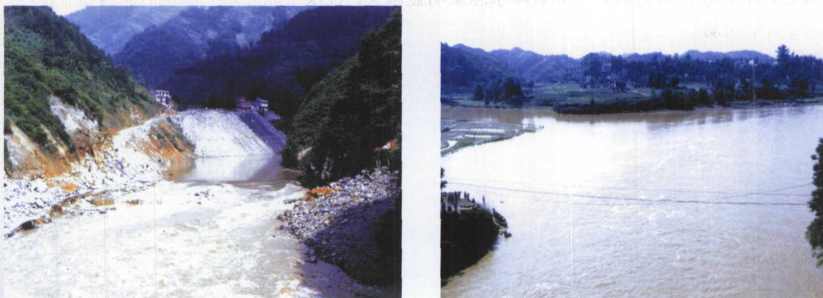
图4.17.1 2004年5月27日湖北省恩施市城郊清江大龙潭水电站上游围堰被突发洪峰冲垮(湖北省气象局提供)
